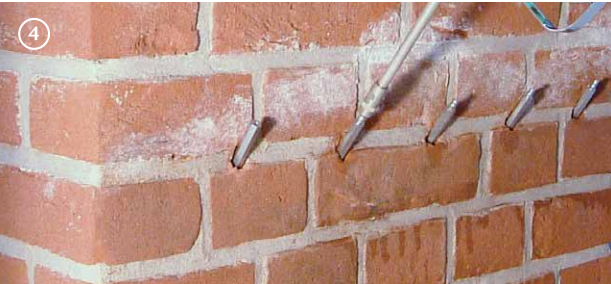
Injektsioontäitmine PU-injektsioonvaiguga
