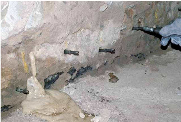
Õõnsustega müüritise esialgne injektsoontäitmine PU-injektsoonvahtvaiguga
