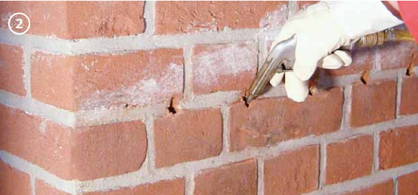
Puurimistolmu eemaldamine
