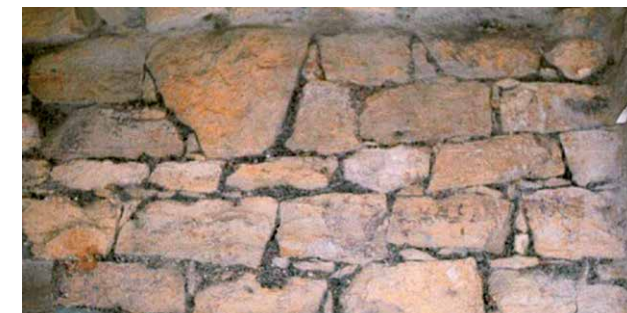
Suurte kividega kükloopmüüritis suurte pooridega vuukidega
