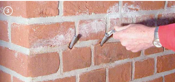
Mehaaniliste pakkerite paigaldamine
