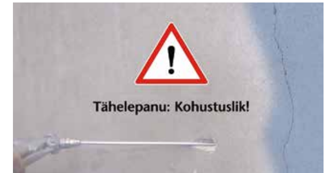
Joonis 2. Puurimistolmu eemaldamine
