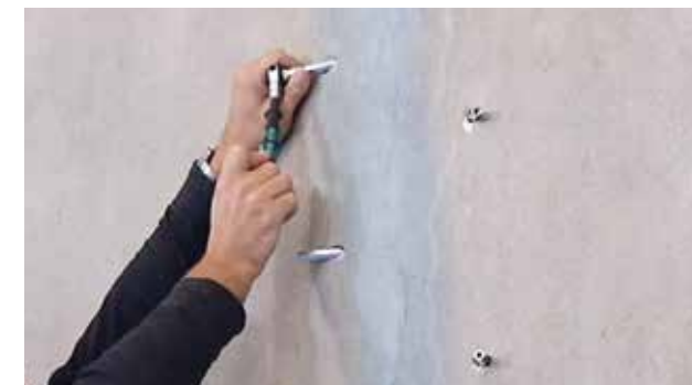
Joonis 3. Puurpakkerite paigaldamine
