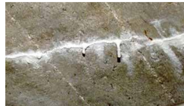
Tsemendimineraalide väljalahustumine
