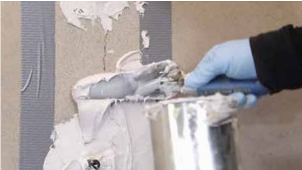
Joonis 4. Pinnapealsete pakkerite praotammistus ja liimimine
