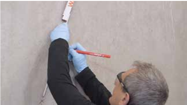
Joonis 2. Pinnapealsete pakkerite vahekauguse määramine prao kohal
