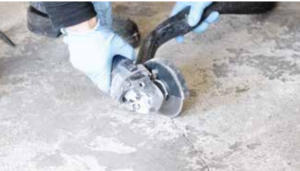
Joonis 1. Laiendage pragu vao kujulise lõikamisega
