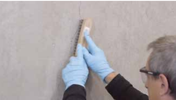
Joonis 1. Pinna puhastamine
