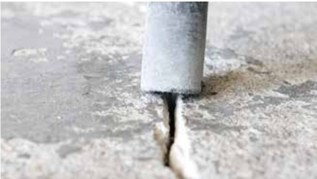
Joonis 2. Eemaldage tolm täielikult
