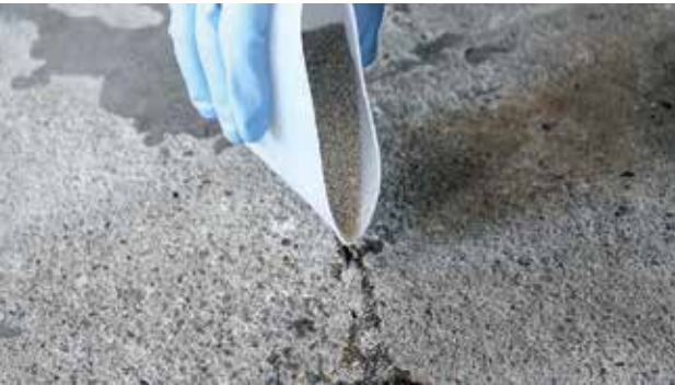
Joonis 5. Praole kvartslüüa puistamine pärast täitvat valamist
