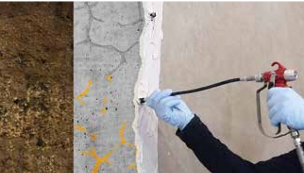
Joonis 5. Injektsioontäitmine alt ülespoole
