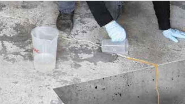
Joonis 4. Prao täis valamine epoksüvaiguga
