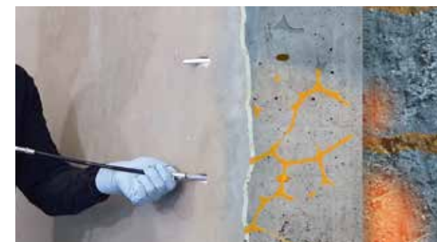
Joonis 5. Injektsoontäitmine alt ülespoole
