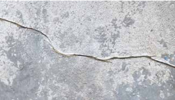
Joonis 3. Ettevalmistatud pragu enne valamist
