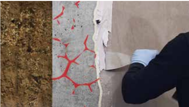
Joonis 6. Praotammistusseguga ja pakkerite eemaldamine
