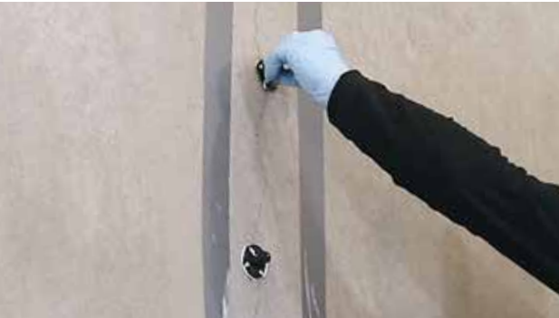
Joonis 3. Pinnapealsete pakkerite paigutamine
