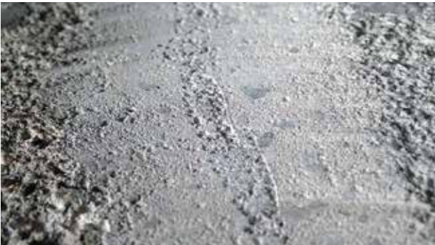
Joonis 6. Pragu pärast täitmist ja lihvimist
