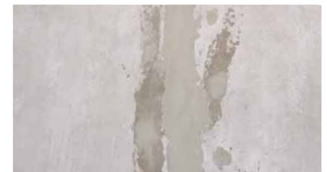
Joonis 6. Pakkerite eemaldamine, pragude katmine ja järeltöötlus
