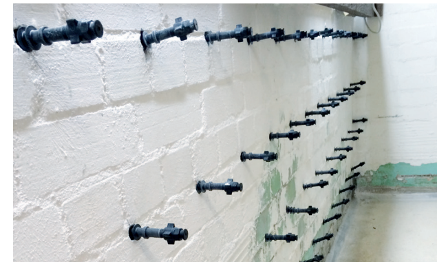
Joonis 2. Pakkerite paigutamise näide
