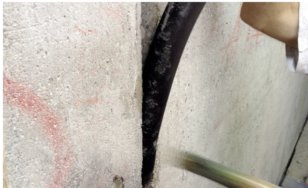
Joonis 3. Haamriga sisselöödava profiili paigaldamine
