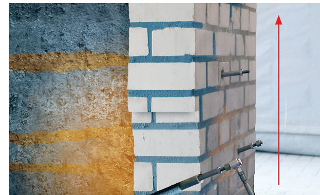
Joonis 3. Injektsoontäitmine suunaga alt ülespoole
