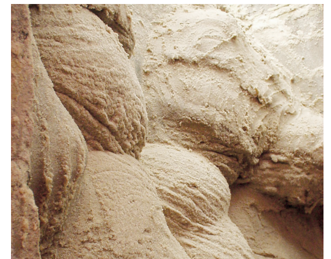
Geeli kardininjektsioon liivas, vundamendi välispinnal
