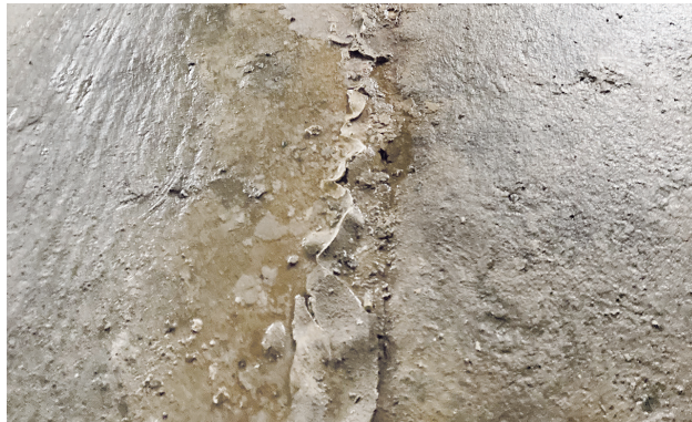
Joonis 1. Vuugi tegelik seisukord enne injekteerimist
