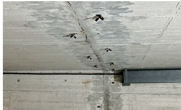
Joonis 4. Pragude tammistamine (ajutine katmine), avade puurimine ja pakkerite paigaldamine
