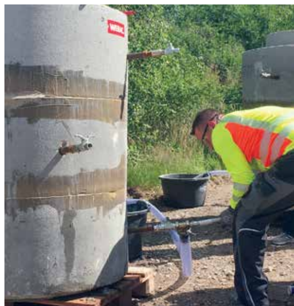
Injektsioontäitmine WEBAC® HIS-iga
